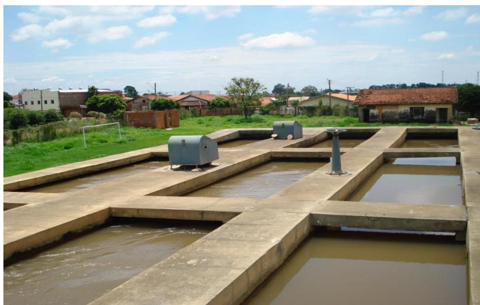
**Figura 6.7 - Floculadores, com Agitadores Mecânicos, da ETA Peixe.**
