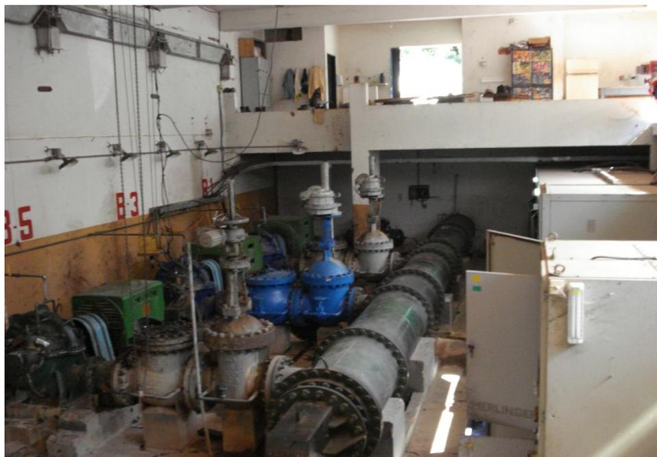
**Figura 6.4 - Conjuntos motor-bomba do 1º Recalque do Sistema de Bombeamento de Água Bruta do Rio do Peixe.**
