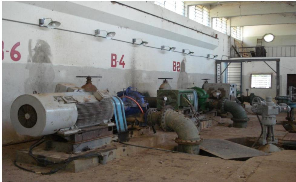
**Figura 6.5 - Conjuntos motor-bomba do 2º Recalque do Sistema de Bombeamento de Água Bruta do Rio do Peixe.**
