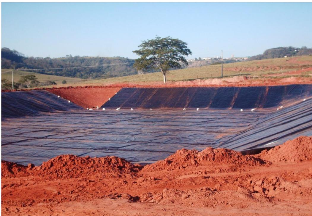
**Figura 7.1 – Uma das lagoas aeradas da ETE Barbosa, já recoberta com manta impermeabilizante – Foto registrada em agosto 2014.**
