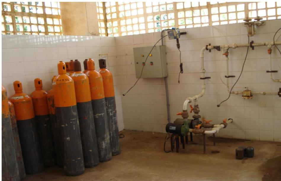
**Figura 6.6 - Sistema de Cloração localizado na ETA Peixe.**
