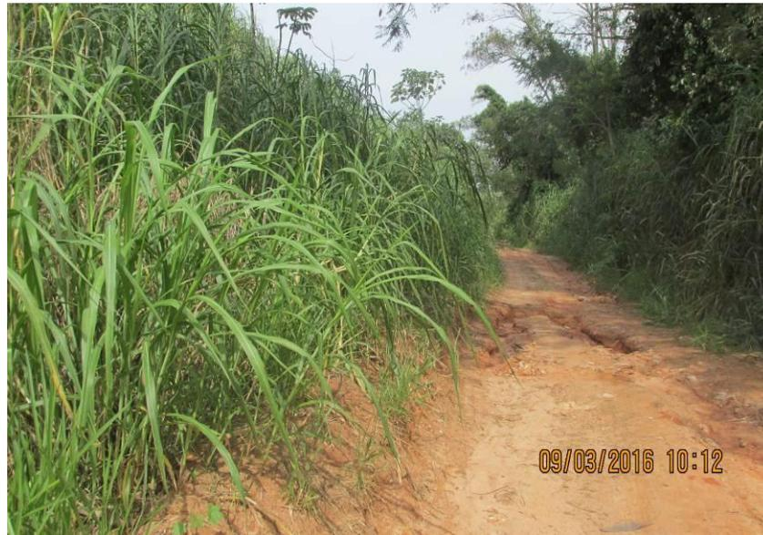
Figura 329 - Processo erosivo no leito carroçável.
