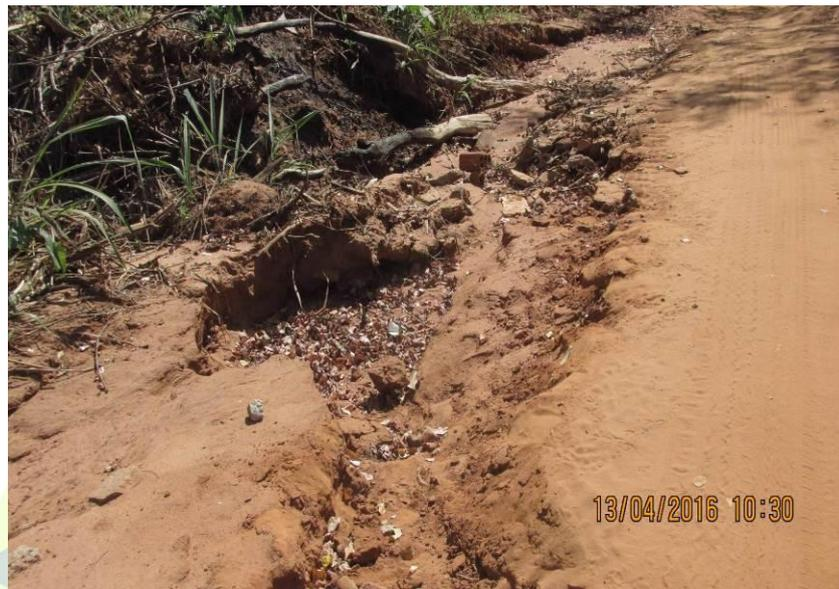
Figura 57 - Erosão na lateral da estrada.
