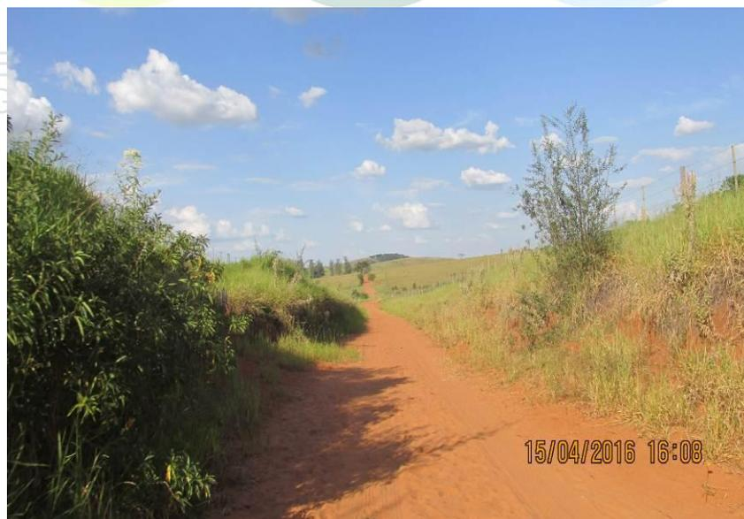
Figura 186 - Ausência de saída d'água.
