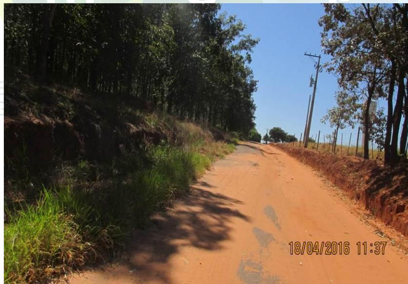
Figura 170 - Ausência de sistema de drenagem.
