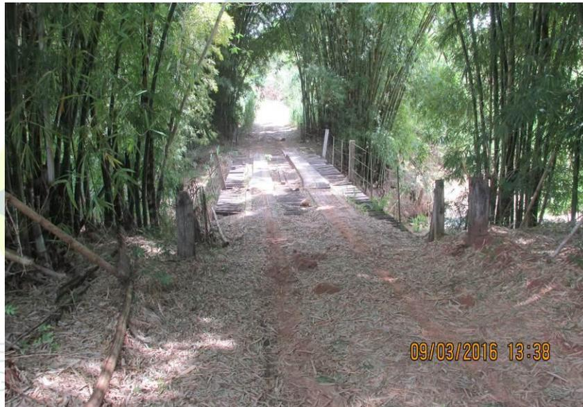
Figura 272 - Ponte de madeira medindo 14,80 x 4,30 x 5,20 metros.
