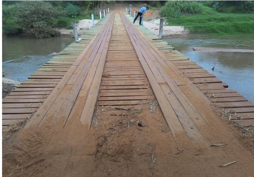
Figura 315 – Ponte de madeira medindo, 49,00 x 4,20 x 4,00 metros.
