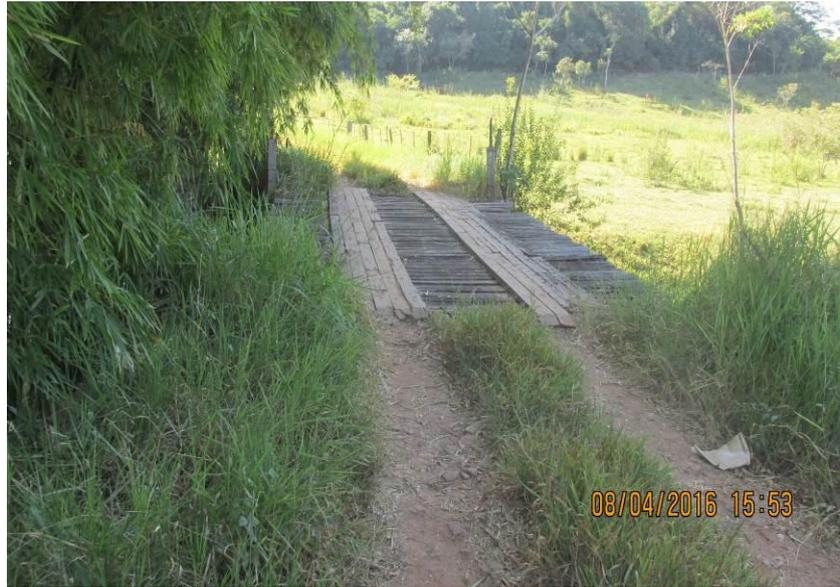
Figura 77 - Ponte de madeira de 7,40 x 4,80 x 2,50 metros.
