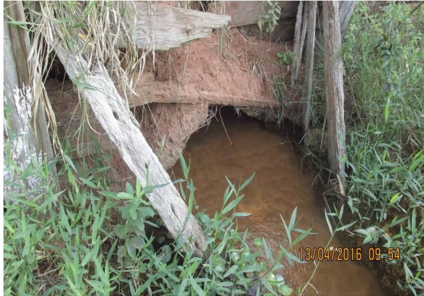
Figura 241 - Tubulação de concreto de 800 mm.
