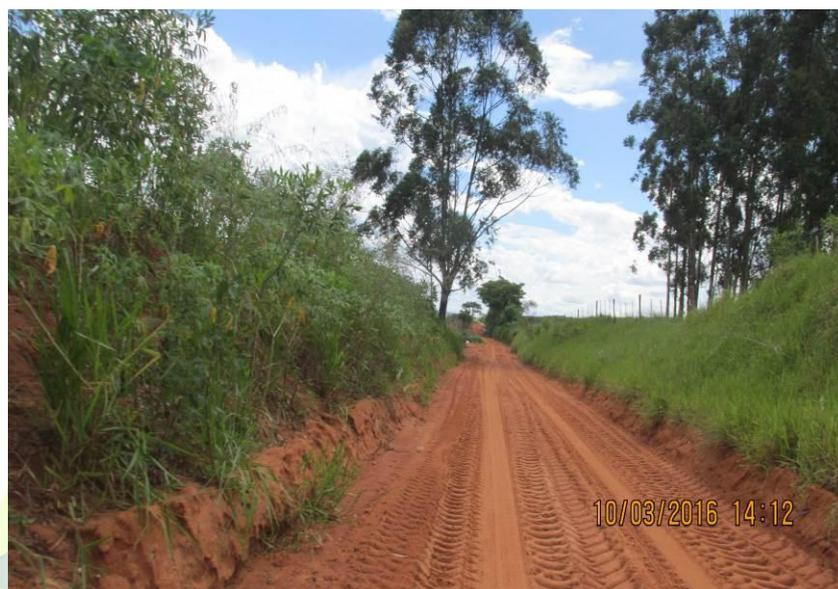
Figura 319 - Ausência de saída d'água e areião.
