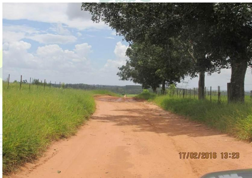
Figura 33 - Ausência de revestimento.
