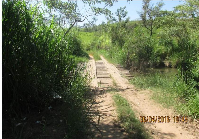
Figura 282 - Ponte de madeira com 16,70 x 4,60 x 4,00 metros.
