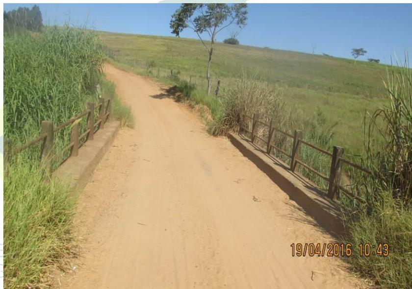
Figura 142 - Ponte de alvenaria com 11,20 x 6,00 x 4,20 metros.
