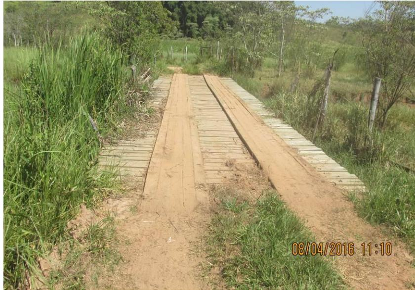
Figura 97 - Ponte de madeira de 17,40 x 4,40 x 3,80 metros.
