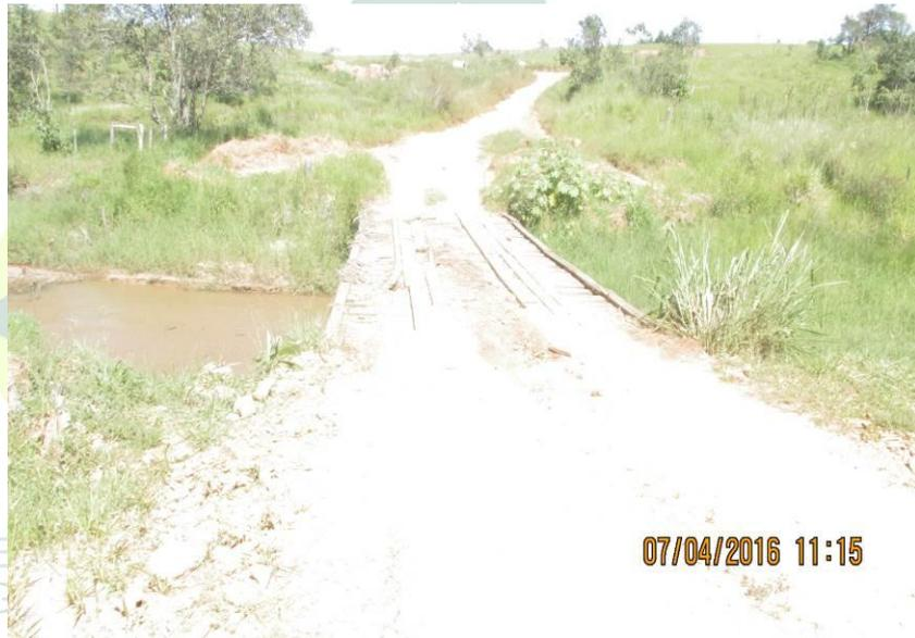
Figura 312 - Ponte de madeira com 15,90 x 4,20 x 2,10 metros.
