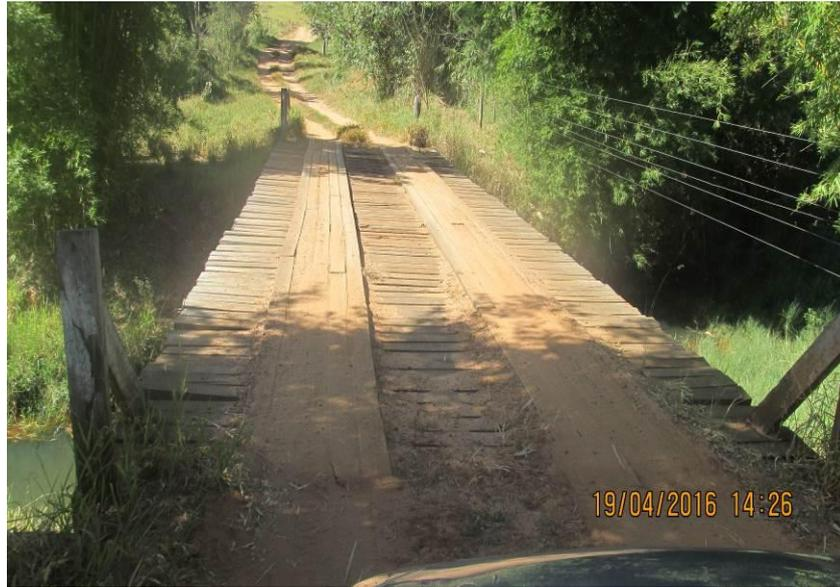
Figura 131 - Ponte de madeira de 16,00 x 4,40 x 4,60 metros.
