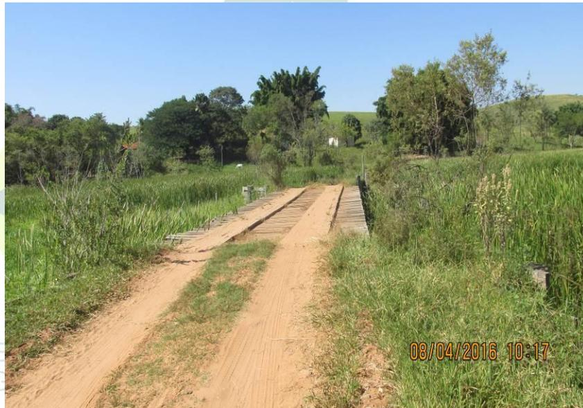
Figura 111 - Ponte de madeira de 18,60 x 4,40 x 2,50 metros.
