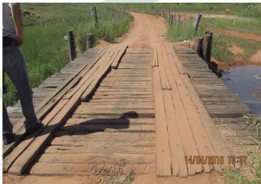
Figura 230 - Ponte de madeira com 8,00 x 4,60 x 4,20 metros.
