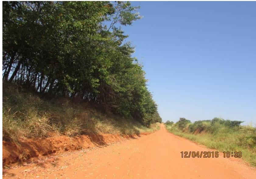
Figura 63 - Plataforma não conformada e barranco.
