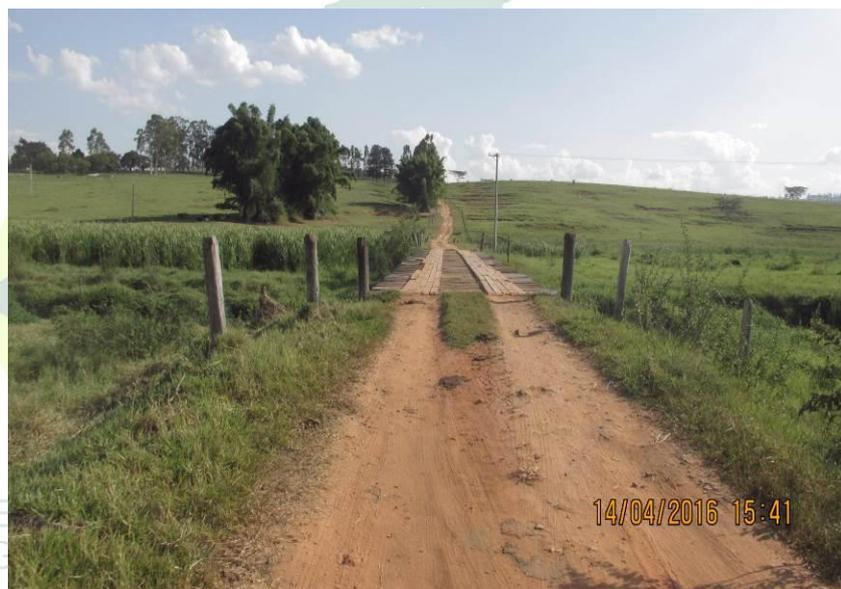
Figura 214 - Ponte de madeira com 34,00 x 4,40 x 5,40.
