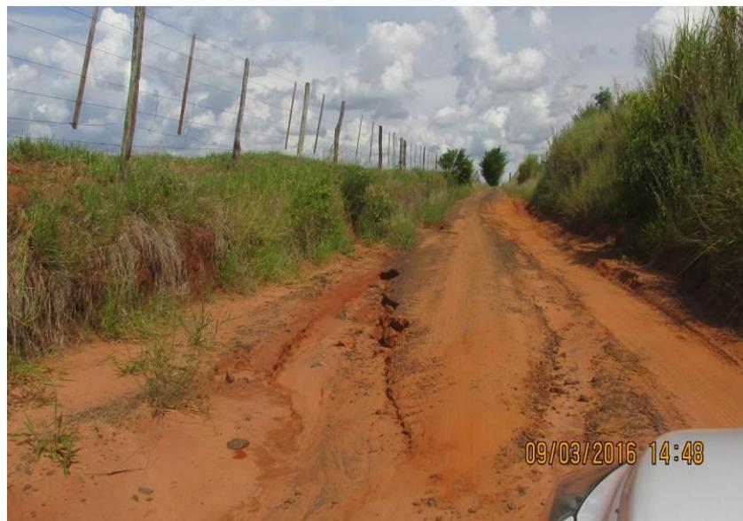
Figura 331 - Processo erosivo na lateral da estrada.
