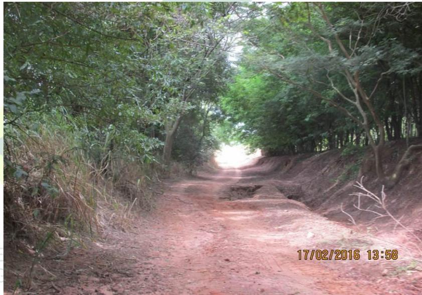
Figura 38 - Erosão na lateral da estrada.
