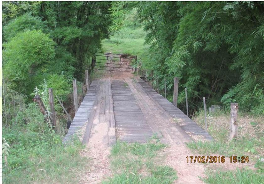
Figura 46 - Ponte de madeira, dimensões 20,40 x 4,60 x 5,60 metros.
