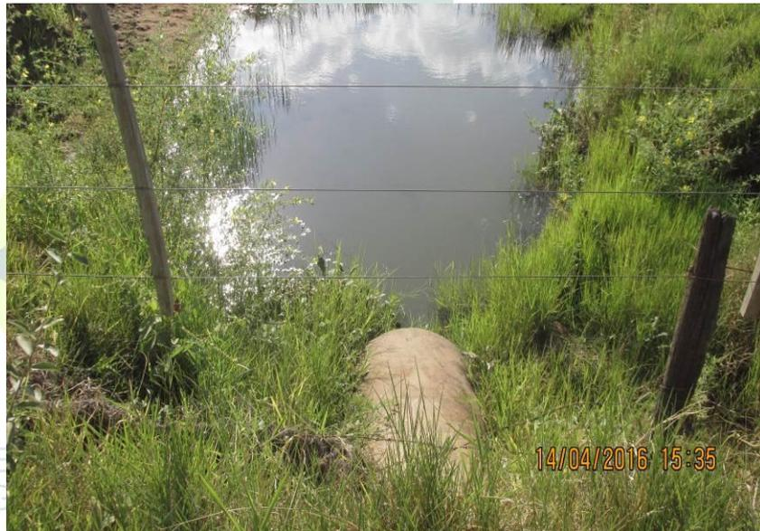
Figura 212 - Duas tubulações de 800 mm de concreto.
