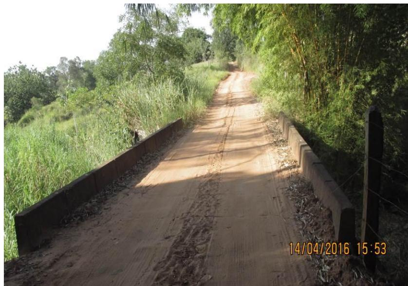
Figura 215 - Ponte de alvenaria medindo 11,20 x 4,40 x 2,60 metros.
