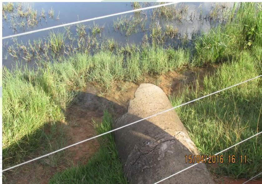
Figura 188 - Tubulação de concreto de 800 mm.
