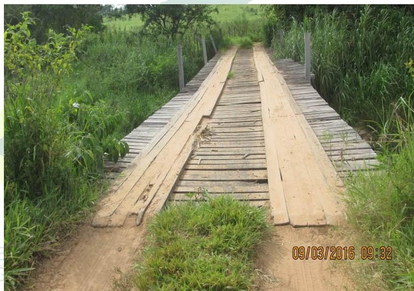
Figura 325 - Ponte de madeira com 24,70 x 4,40 x 3,70 metros.
