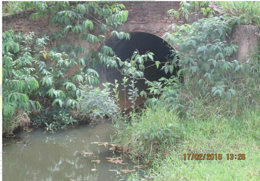
Figura 35 - Tubulação de armco de 2500 mm.
