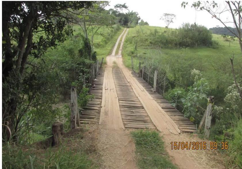
Figura 198 - Ponte de madeira medindo 19,20 x 4,10 x 4,80 metros.
