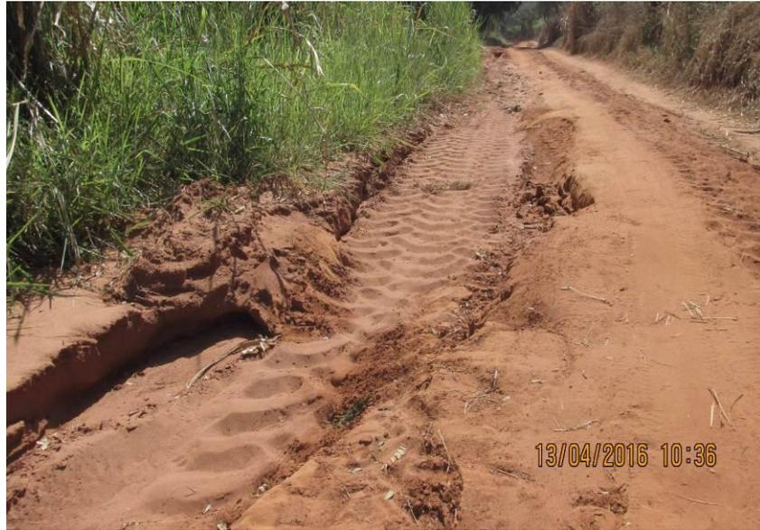
Figura 59 - Processo erosivo na lateral da estrada.
