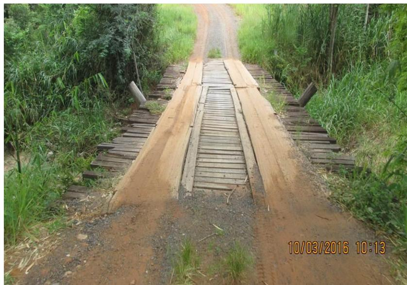
Figura 269 - Ponte de madeira com 23,40 x 4,70 x 3,60 metros.
