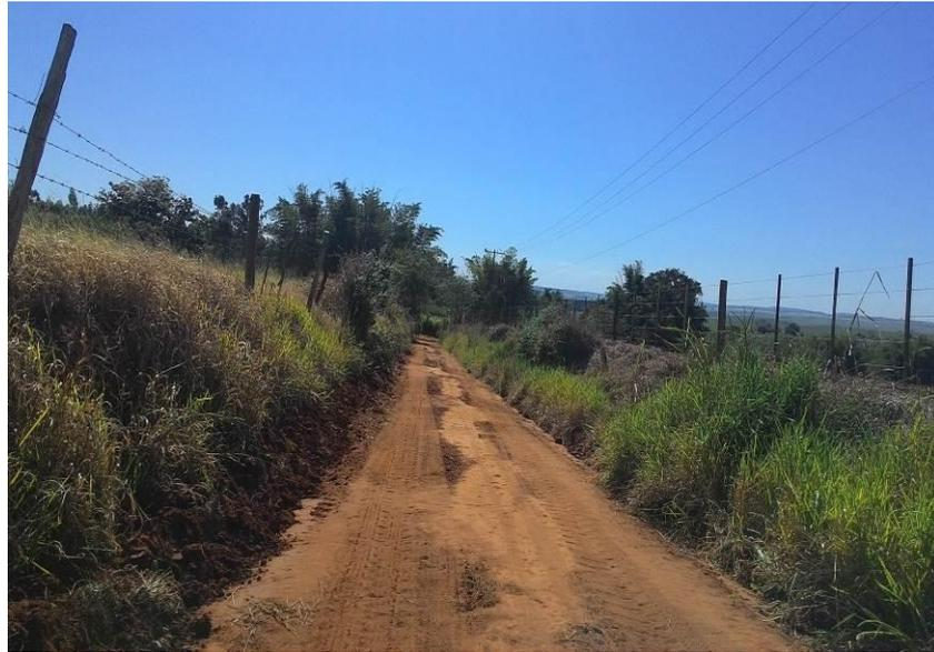
Figura 263 - Ausência de saída d'água.
