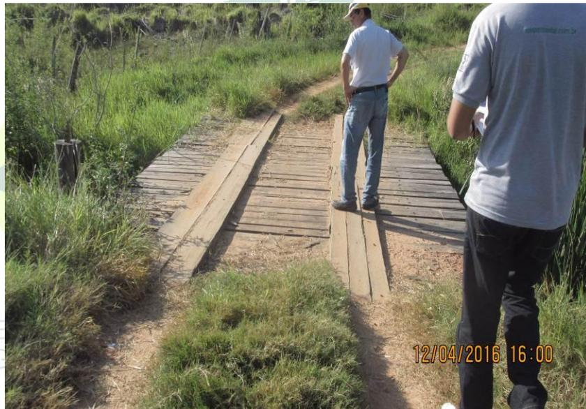
Figura 260 - Ponte de madeira medindo 10,20 x 4,40 x 3,60.
