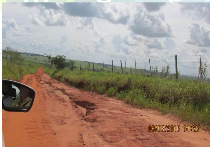
Figura 314 - Processo erosivo na lateral da estrada.
