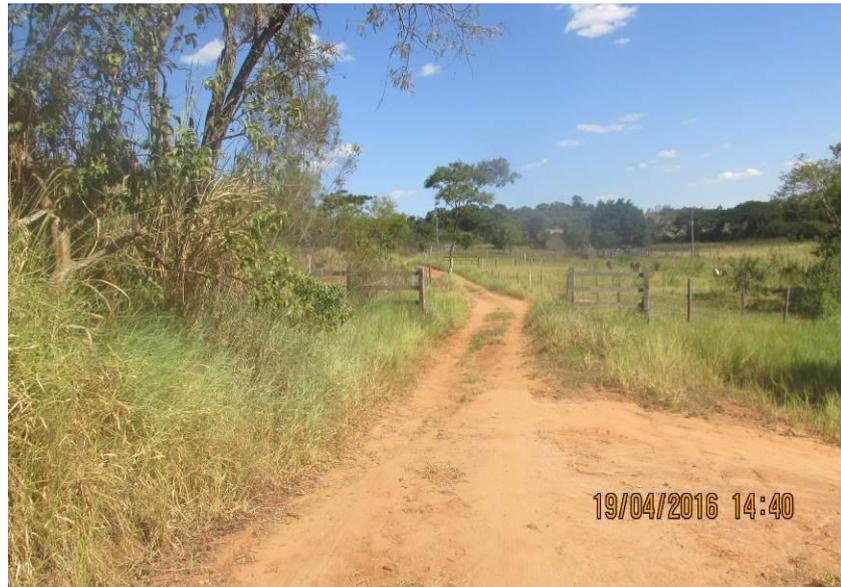
Figura 133 - Ausência de revestimento.
