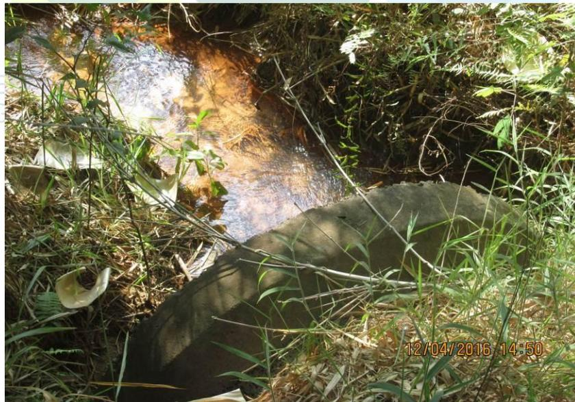
Figura 50 - Tubulação de concreto de 1500 mm.
