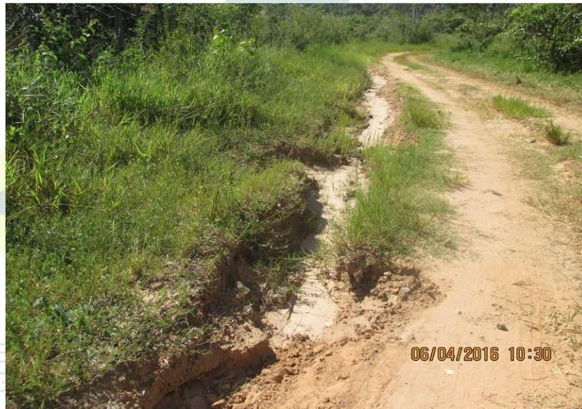
Figura 279 - Processo erosivo na lateral da estrada.
