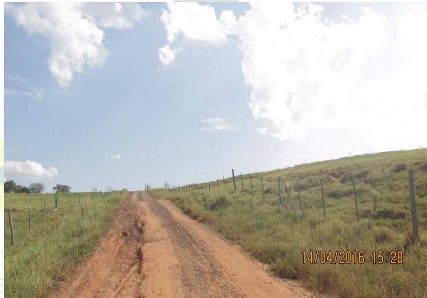
Figura 210 - Processo erosivo no leito carroçável.
