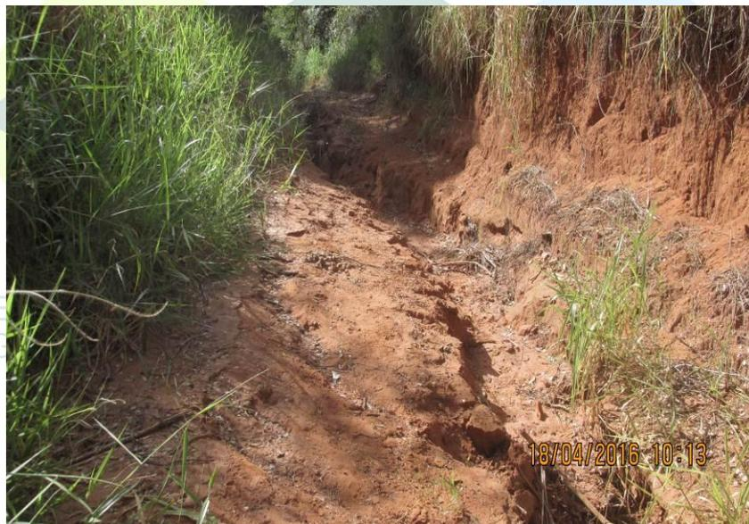
Figura 184 - Processo erosivo no leito carroçável.
