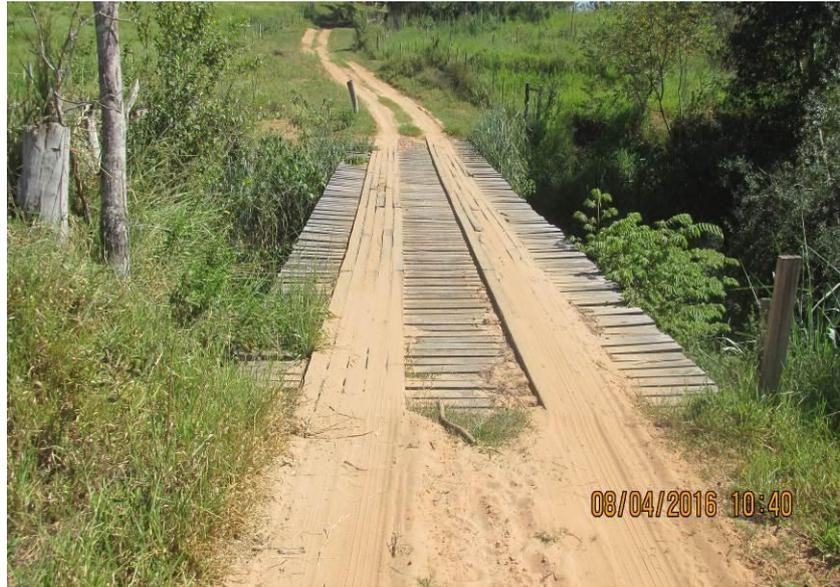
Figura 112 - Ponte de madeira medindo 21,20 x 4,30 x 5,20 metros.
