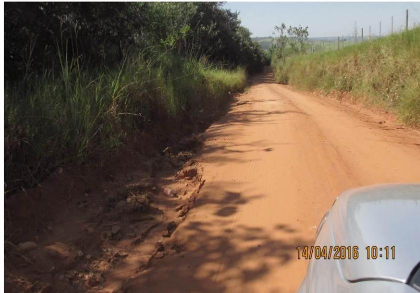
Figura 204 - Processo erosivo na lateral da estrada.
