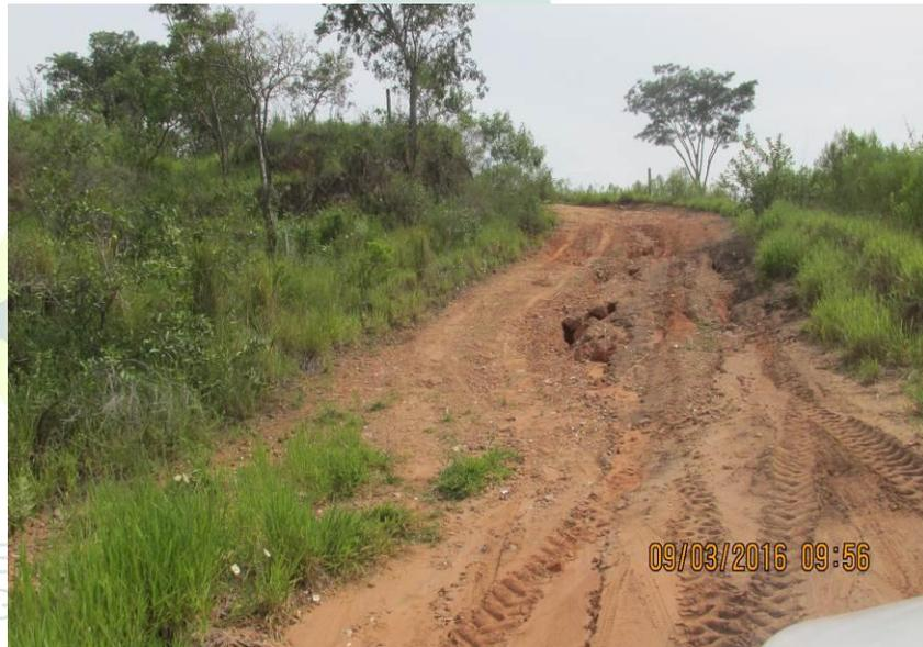
Figura 323 - Processo erosivo no leito carroçável.
