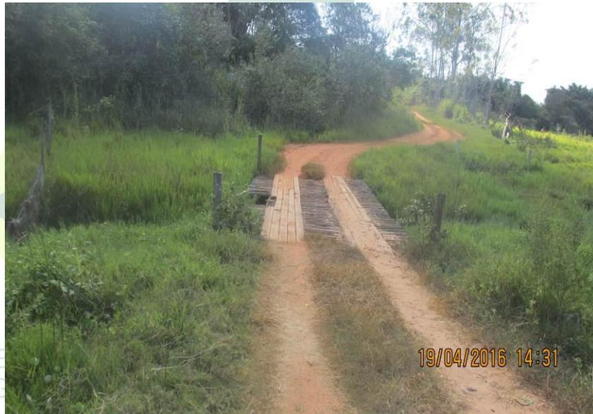
Figura 132 - Ponte de madeira com a plataforma danificada de 9,80 x 4,10 x 2,90 metros.
