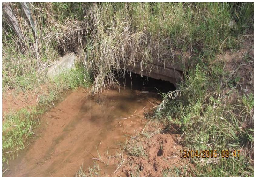
Figura 239 - Aduela de concreto assoreada de 1,5 x 1 m.
