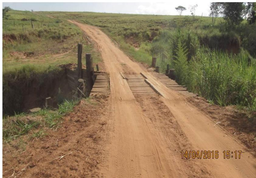
Figura 213 - Ponte de madeira com 7,40 x 4,60 x 4,60 metros.
