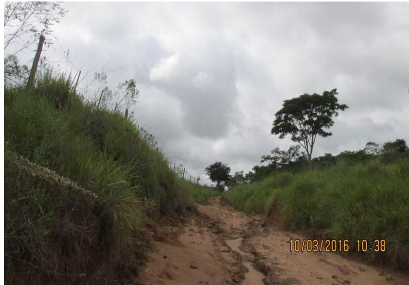
Figura 267 - Processo erosivo no leito carroçável.
