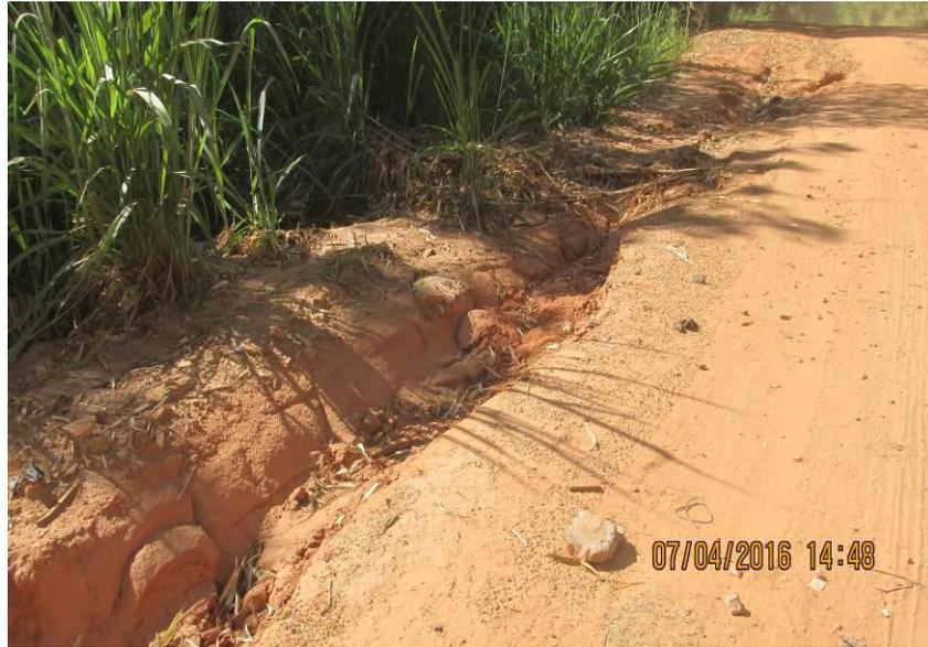
Figura 100 - Processo erosivo na lateral da estrada.
