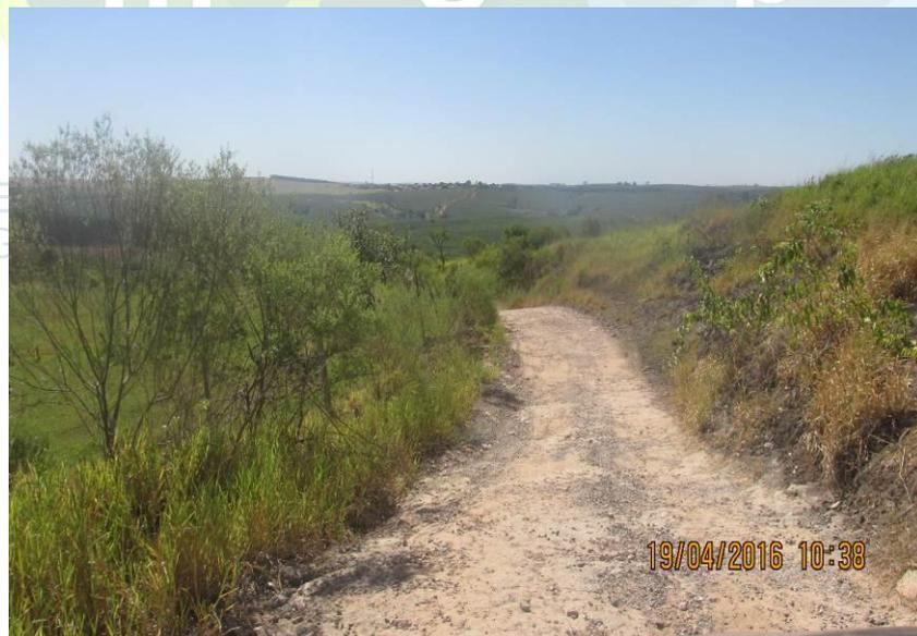
Figura 140 - Trecho revestido com pedra brita.
