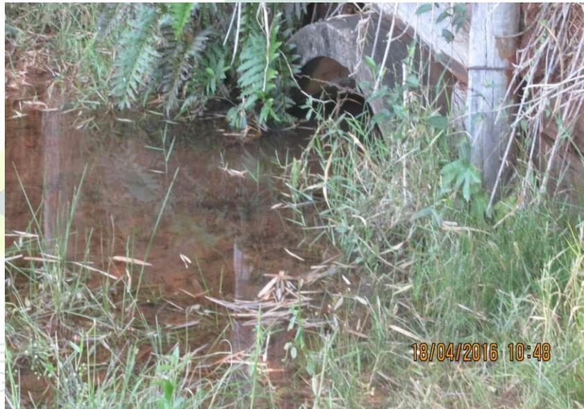
Figura 175 - Tubulação de concreto de 1000 mm.
