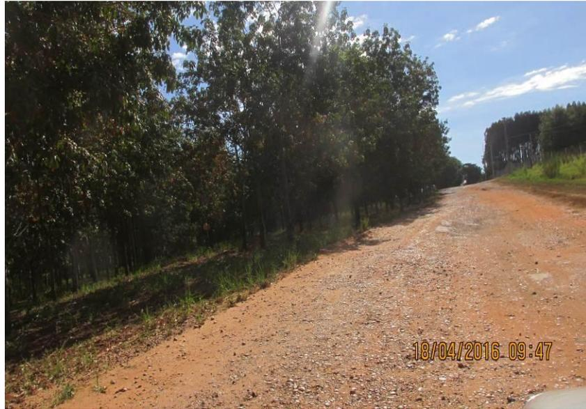
Figura 179 - Revestimento de cascalho.
