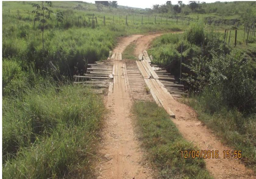
Figura 259 - Ponte de madeira com a plataforma em más condições com medidas de 10,20 x 4,40 x 3,60 metros.
