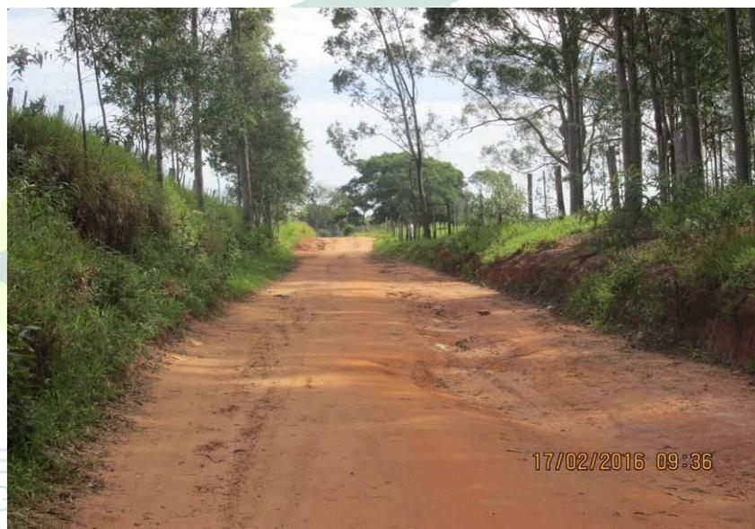
Figura 19 - Trecho sem saída d'água.
