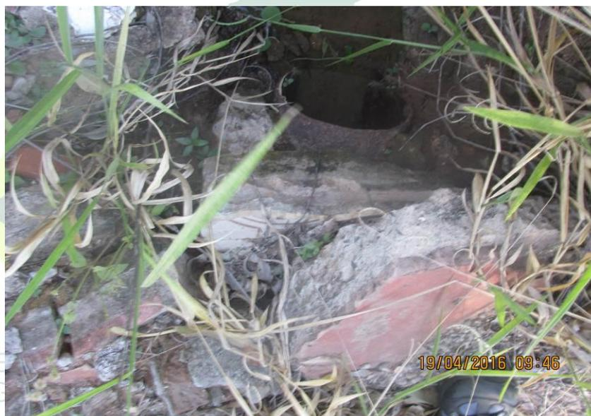
Figura 148 - Tubulação de ferro de 100 mm.
