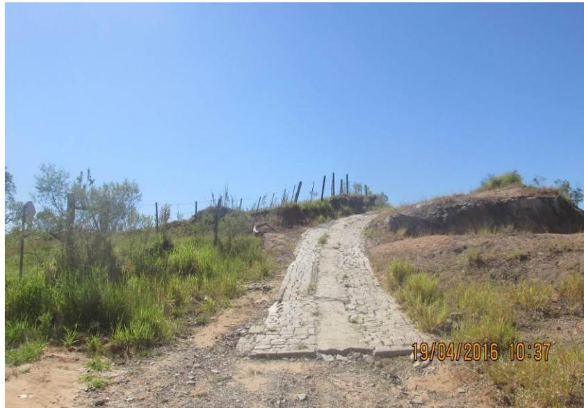
Figura 141 - Revestimento com paralelepípedo.
