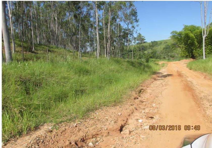
Figura 339 - Processo erosivo na lateral da estrada.
