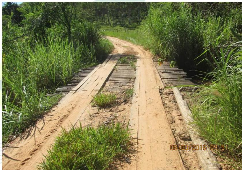
Figura 340 - Ponte de madeira com 12,20 x 4,20 x 1,40 metros.
