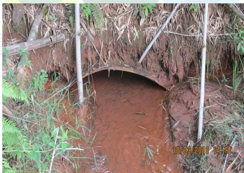
Figura 320 - Tubulação de concreto de 1000 mm.
