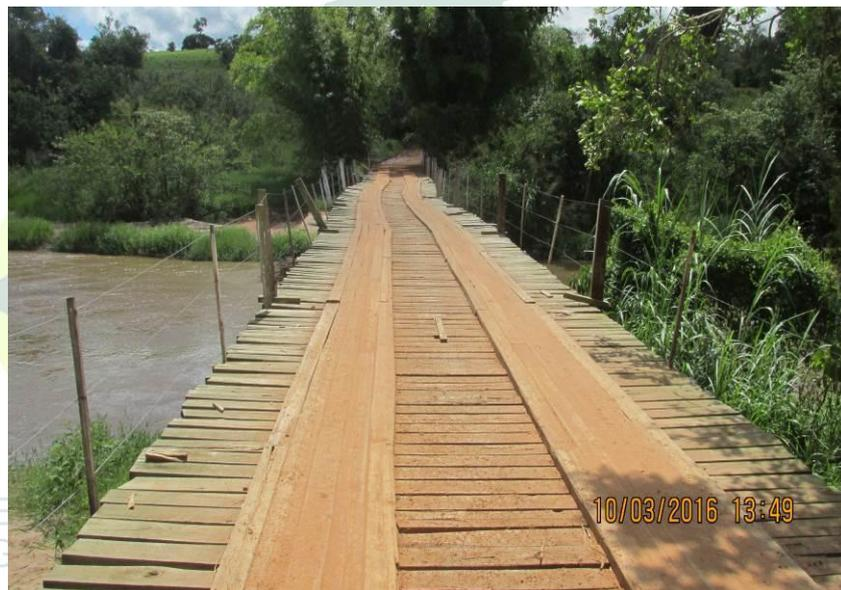
Figura 276 - Ponte de madeira de 54,00 x 4,00 x 3,30 metros.
