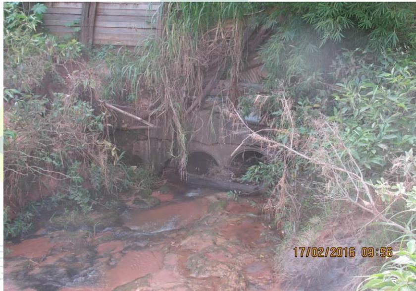
Figura 24 - Duas tubulações de concreto de 800 mm.
