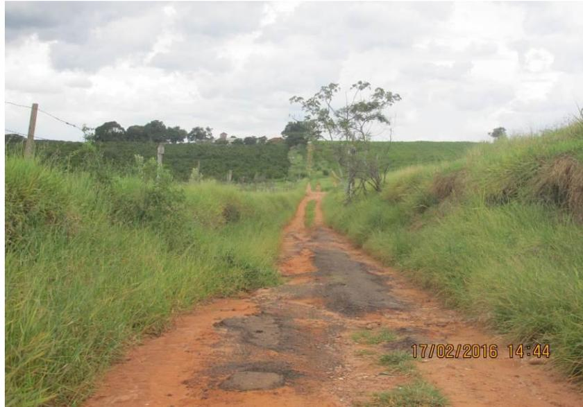
Figura 41 - Trecho revestido com sobras asfálticas.
