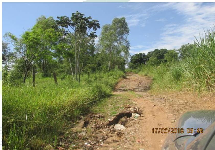
Figura 22 - Erosão no leito carroçável.
