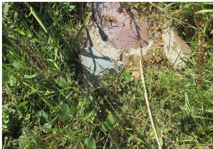
Figura 108 - tubulação de concreto danificada de 600 mm.
