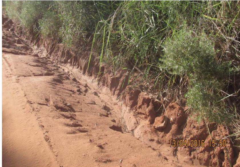
Figura 237 - Processo erosivo na lateral da estrada.
