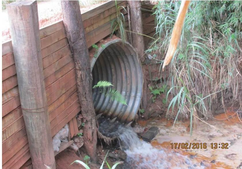
Figura 36 - Tubulação de armco de 1500 mm.
