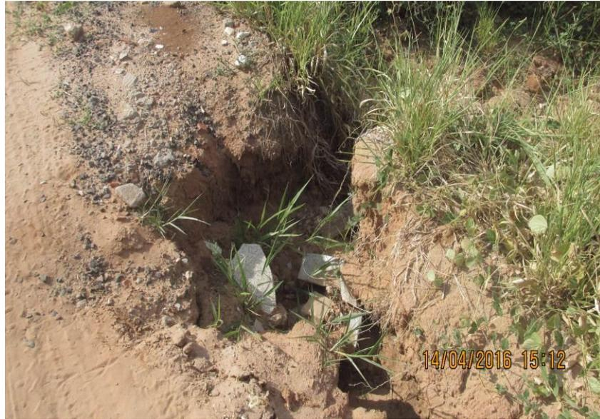
Figura 222 - Processo erosivo na lateral da estrada.
