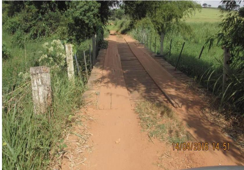
Figura 224 - Ponte de madeira com 20,20 x 4,10 x 4,00 metros.
