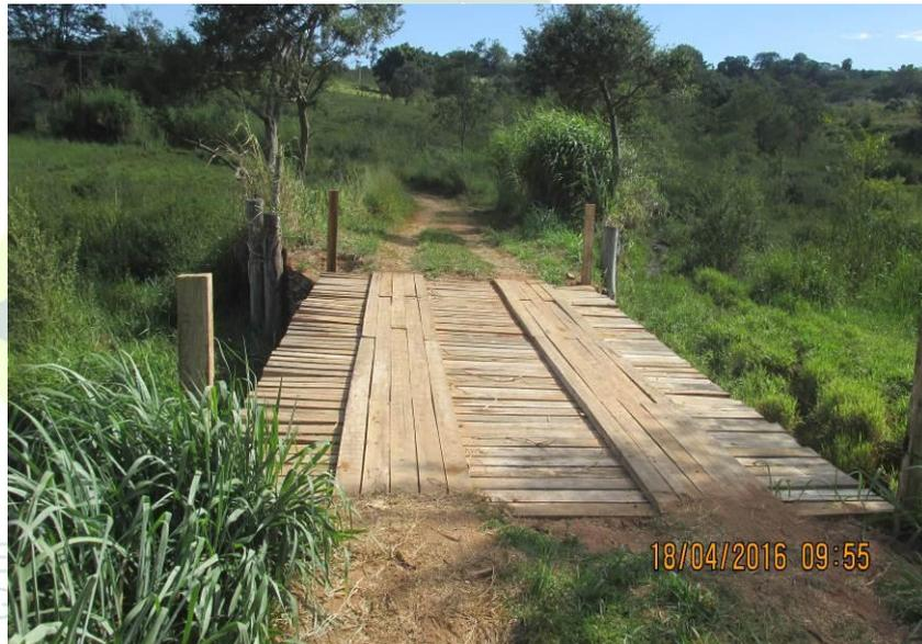
Figura 182 - Ponte de madeira de 10,00 x 4,20 x 3,40 metros.
