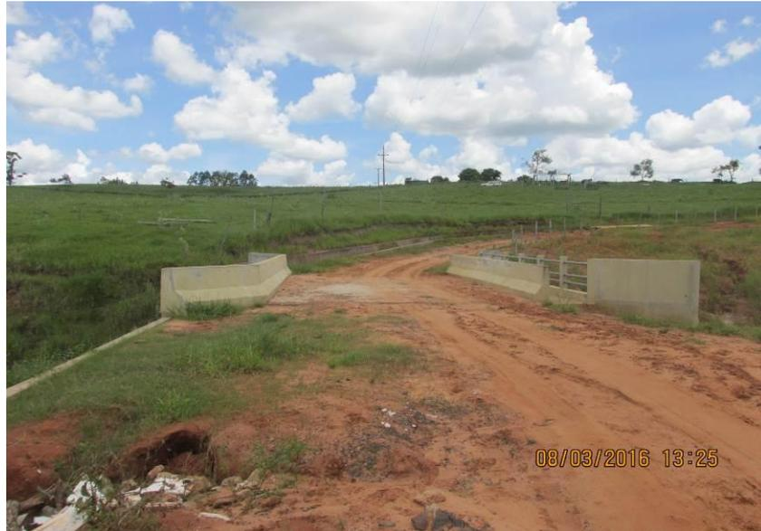
Figura 346 - Ponte de alvenaria medindo 11,40 x 8,30 x 6,60 metros.
