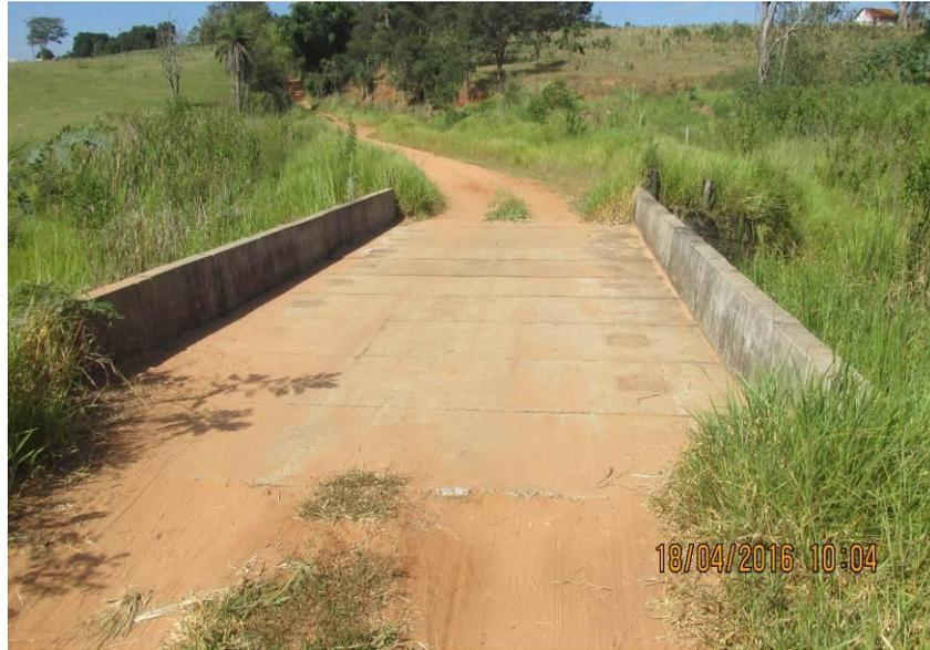
Figura 181 - Ponte de alvenaria de 8,20 x 4,40 x 3,20 metros.
