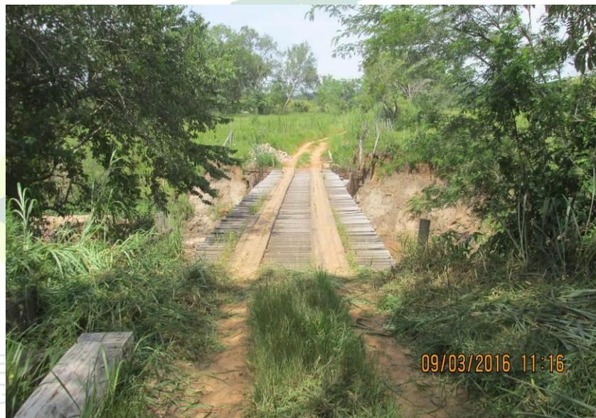
Figura 352 - Ponte de madeira com 27 x 4,30 x 3,70 metros.
