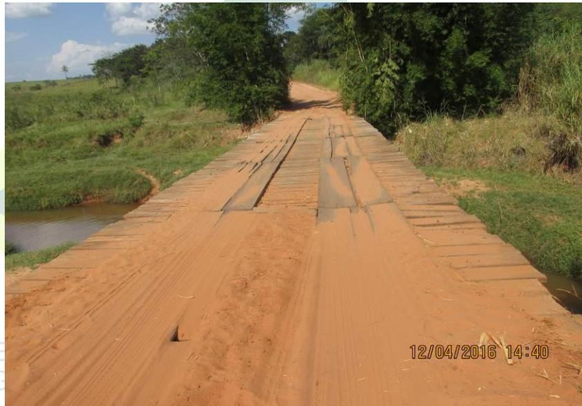
Figura 254 - Ponte de madeira medindo 29,00 x 5,00 x 5,00 metros.
