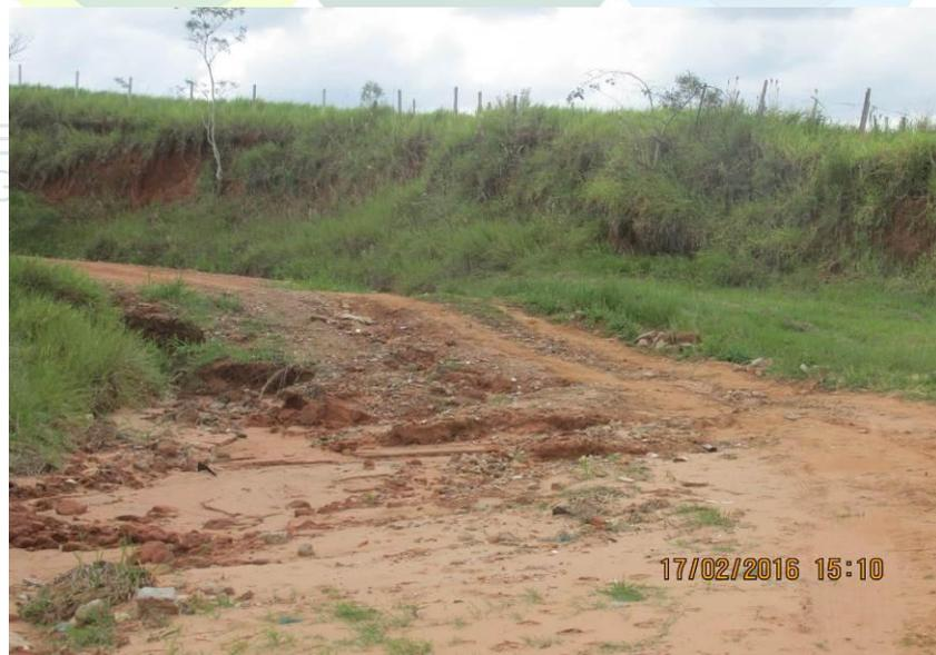
Figura 44 - Erosão na lateral da estrada.
