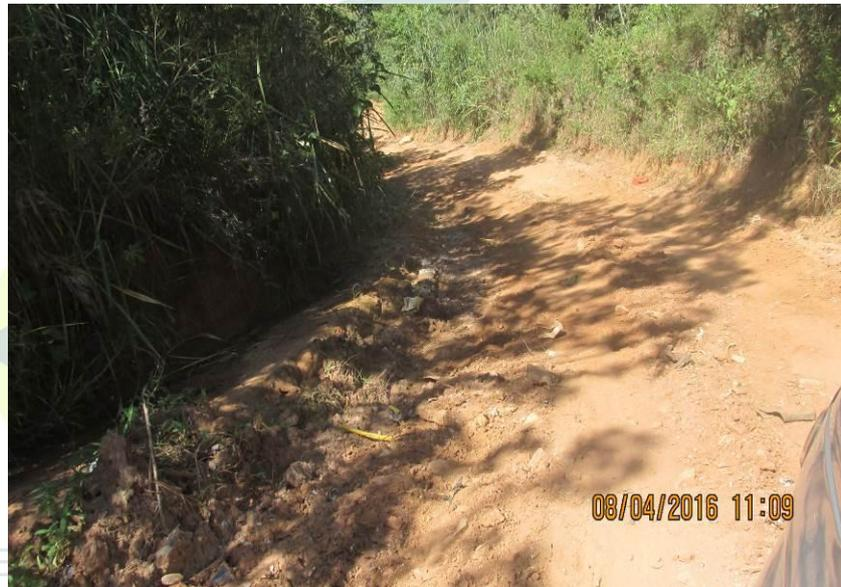
Figura 92 - Processo erosivo na lateral da estrada.
