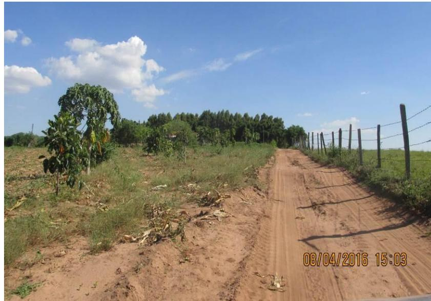
Figura 88 - Ausência de saída d'água.
