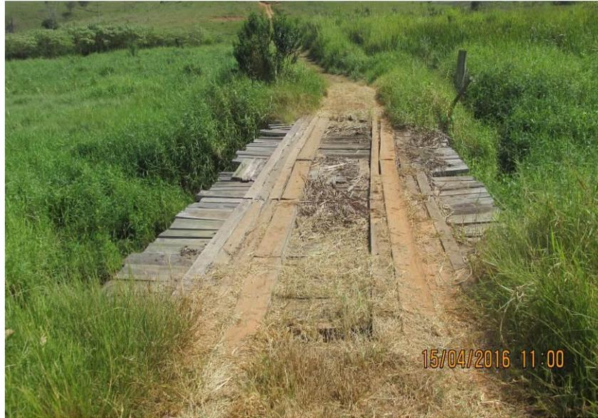
Figura 193 - Ponte de madeira em más condições medindo 11,60 x 4,60 x 2,20 metros.
