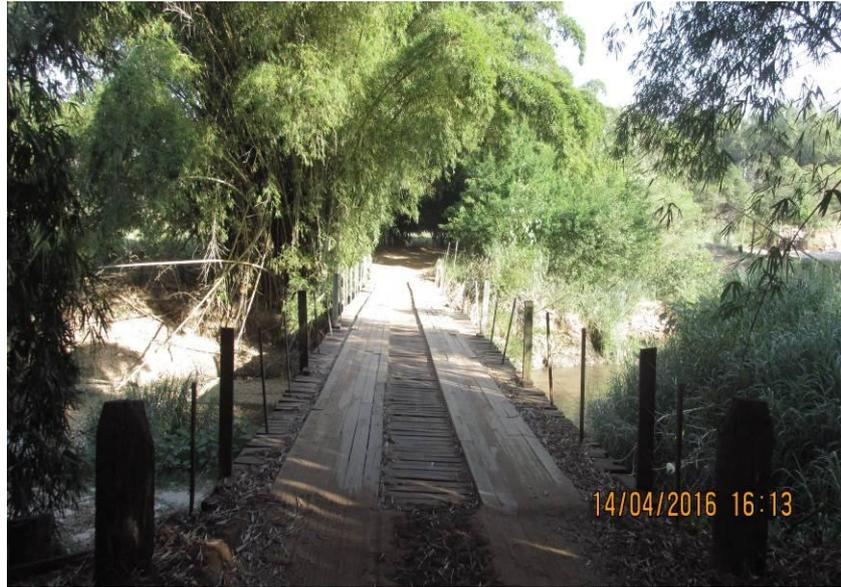
Figura 206 - Ponte de madeira medindo 38,00 x 4,10 x 4,80 metros.
