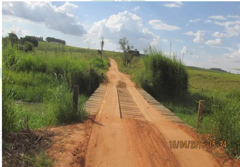
Figura 194 - Ponte de madeira com 14,60 x 4,40 x 2,20 metros.
