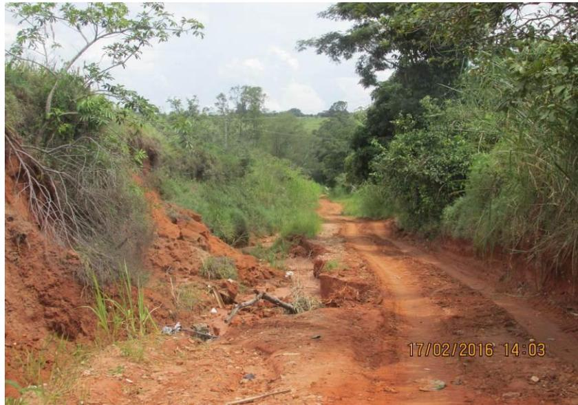
Figura 39 - Processo erosivo na lateral da estrada.
