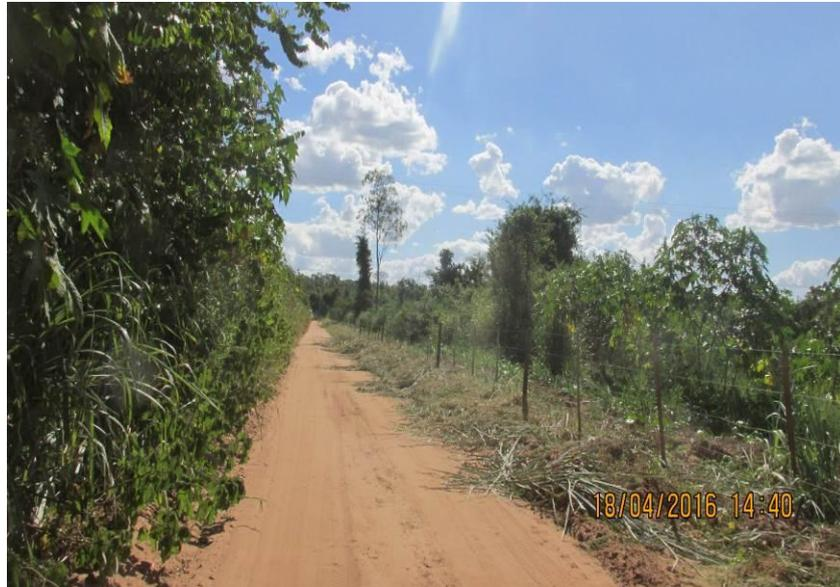
Figura 167 - Ausência de saída d'água.
