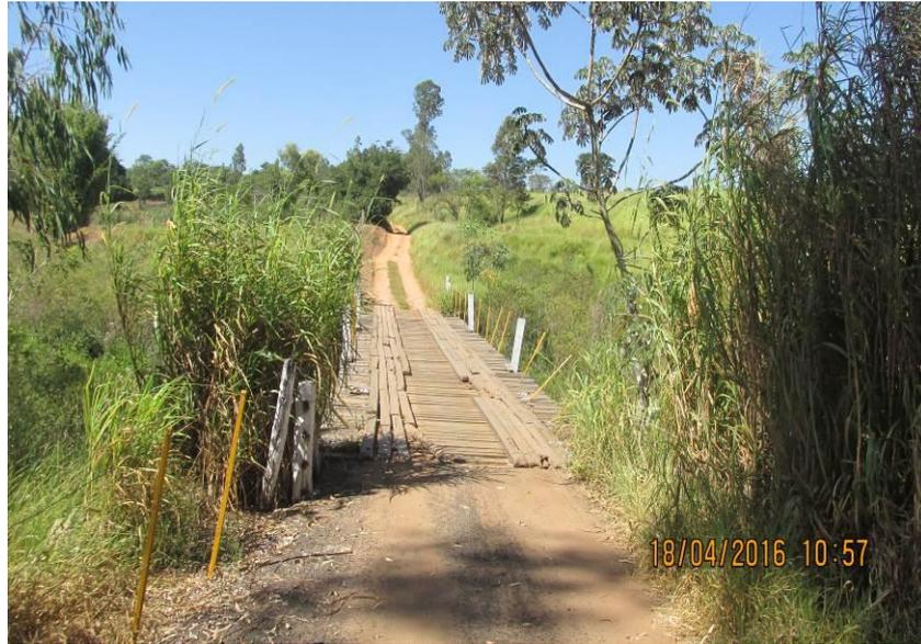
Figura 176 - Ponte de madeira de 23,00 x 4,60 x 4,00 metros.
