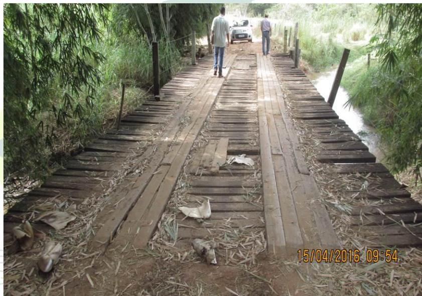
Figura 199 - Ponte de madeira com 19,00 x 4,40 x 2,30 metros.
