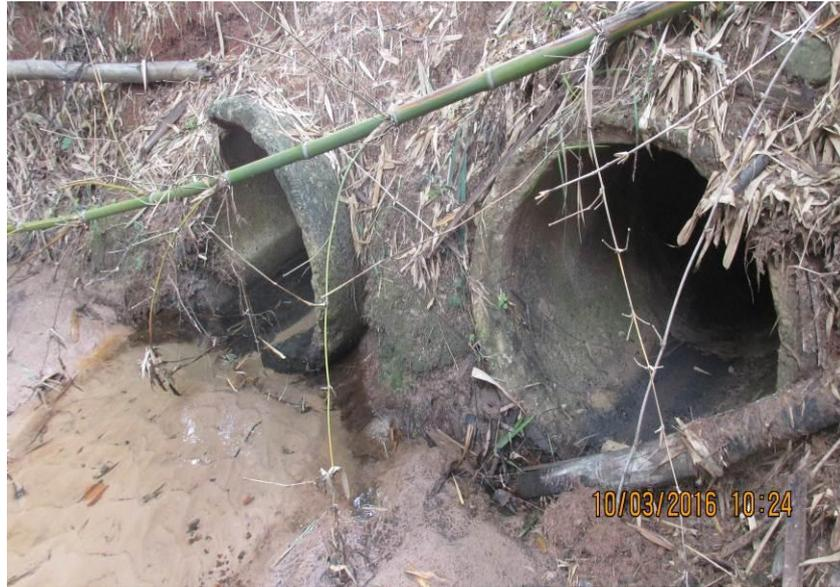
Figura 271 - Duas tubulações de concreto de 800 mm.
