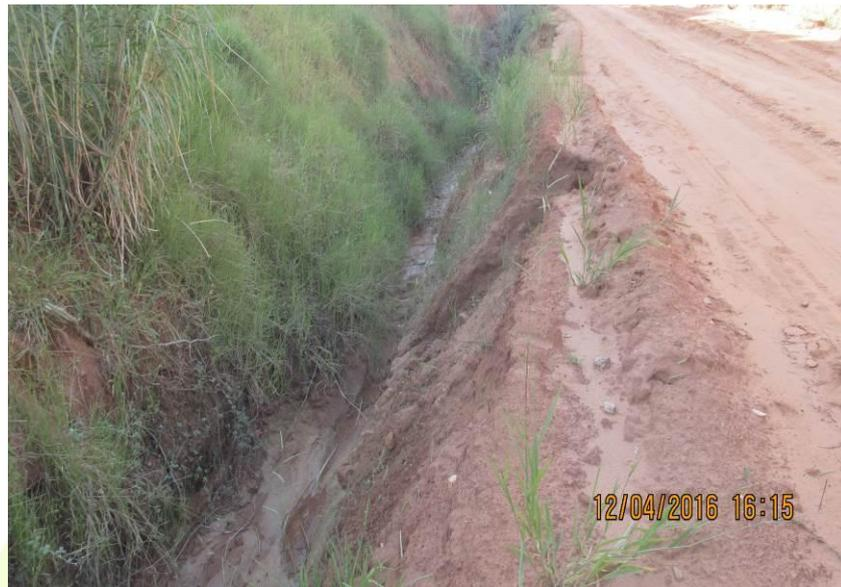
Figura 257 - Processo erosivo na lateral da estrada.
