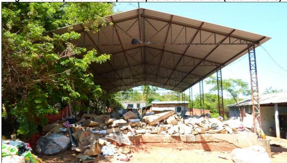
Pode-se verificar que o Galpão utilizado para depósito de materiais, Figura 43, foi construído de forma a auxiliar no descarregamento dos materiais recicláveis pelos veículos coletores, através de pavimento em desnível.
