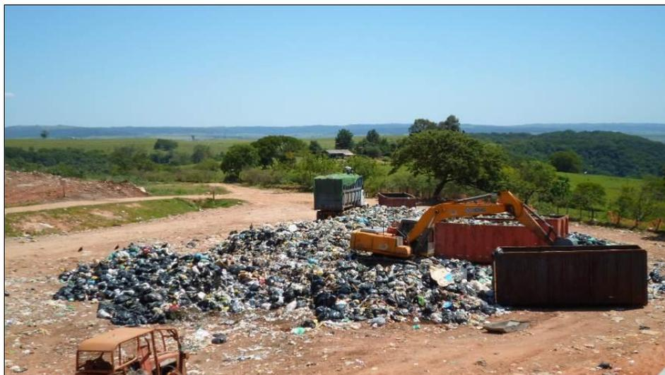
Na Figura 28 pode-se visualizar os resíduos sendo dispostos nas caçambas e na Figura 29 a caçamba preenchida com resíduos acoplada ao caminhão para transporte até o Aterro Sanitário.
