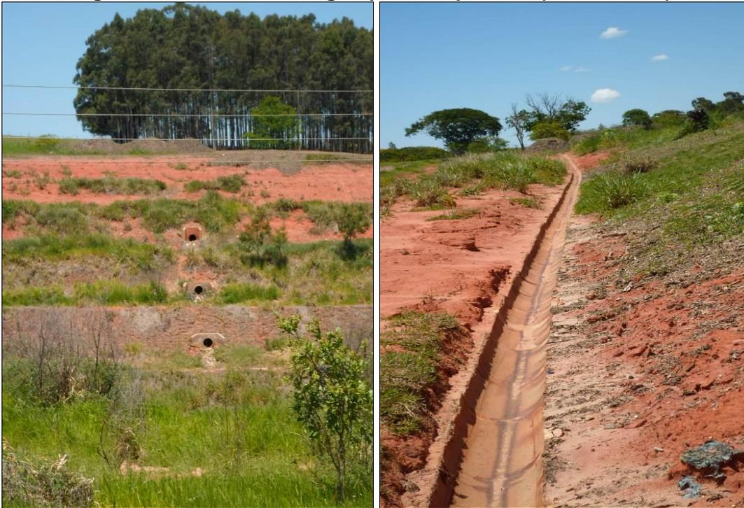
Na Figura 36 observa-se o sistema de drenagem dos gases que possui a função de drenar os gases provenientes da decomposição da matéria orgânica, evitando a sua migração através dos meios porosos que constituem o subsolo, podendo formar bolsões de gás no aterro.
