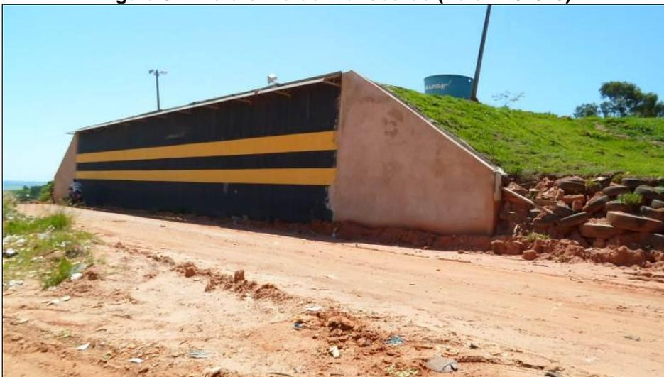
A Plataforma de Transbordo consiste em um talude onde o caminhão compactador sobe para depositar os resíduos dentro do caminhão que fará o transporte até o Aterro Sanitário. Na Figura 32 apresenta-se exemplo de uma Plataforma de Transbordo em operação, nota-se que os resíduos são depositados diretamente no caminhão de maior capacidade, não havendo disposição nem acúmulo de resíduos no chão.
